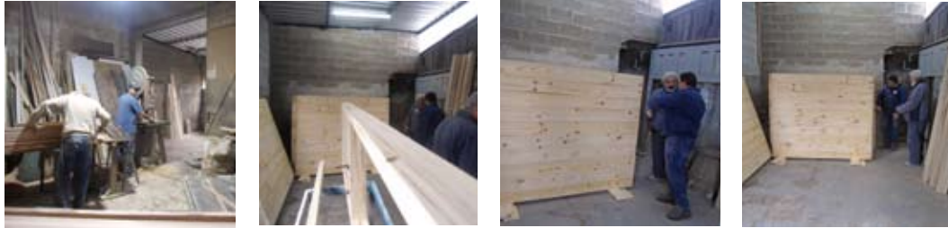
Construcción de embudo para MNAV, 2016
